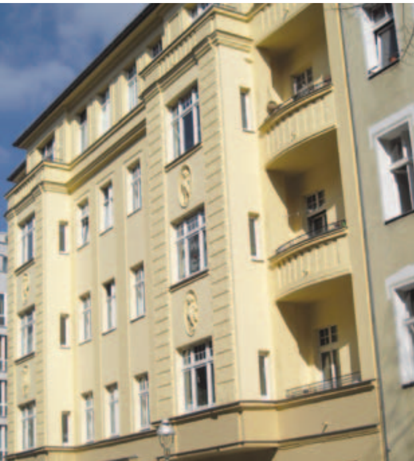
Wiederherstellung der historischen Fassade Mainzer Straße / Reuterstraße.
