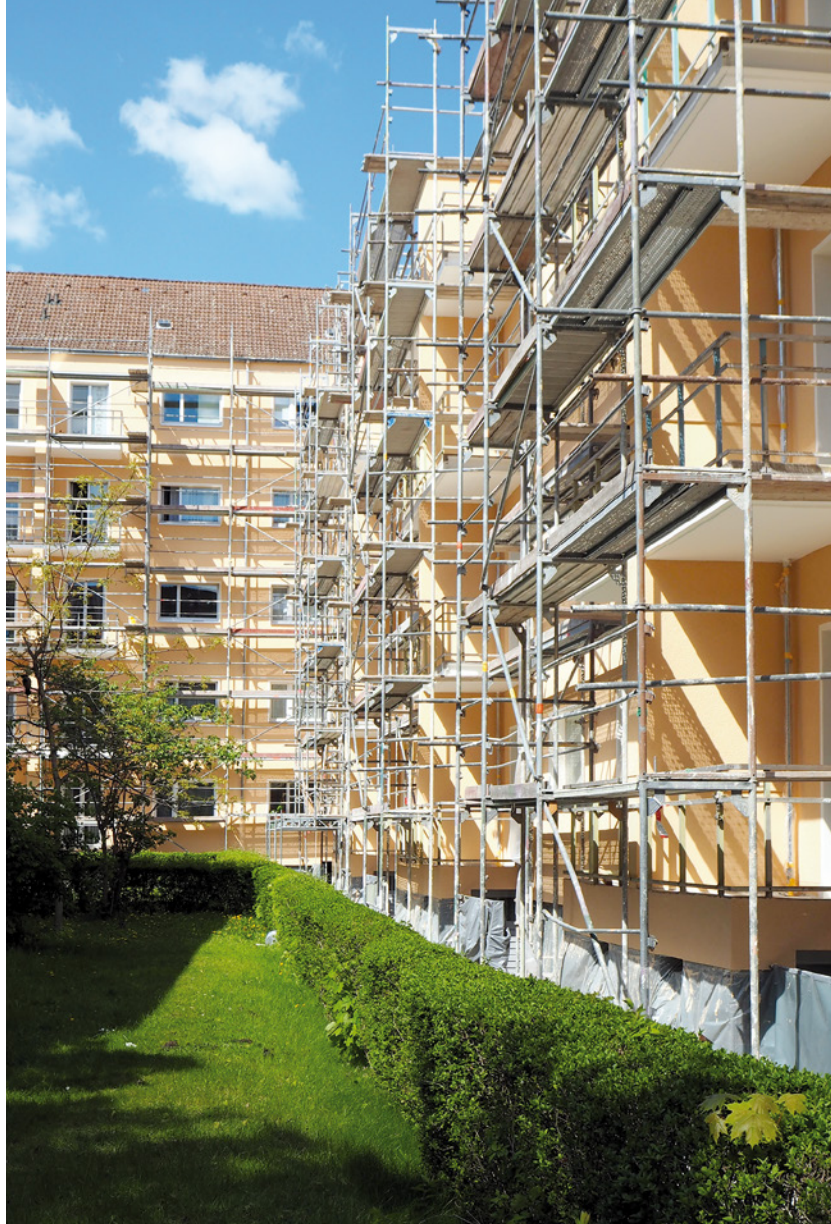
Die Fassade der Anlage Thomasstraße / Ilsestraße / Selkestraße / Jonasstraße wurde saniert. Im Bild noch eingerüstet ...
