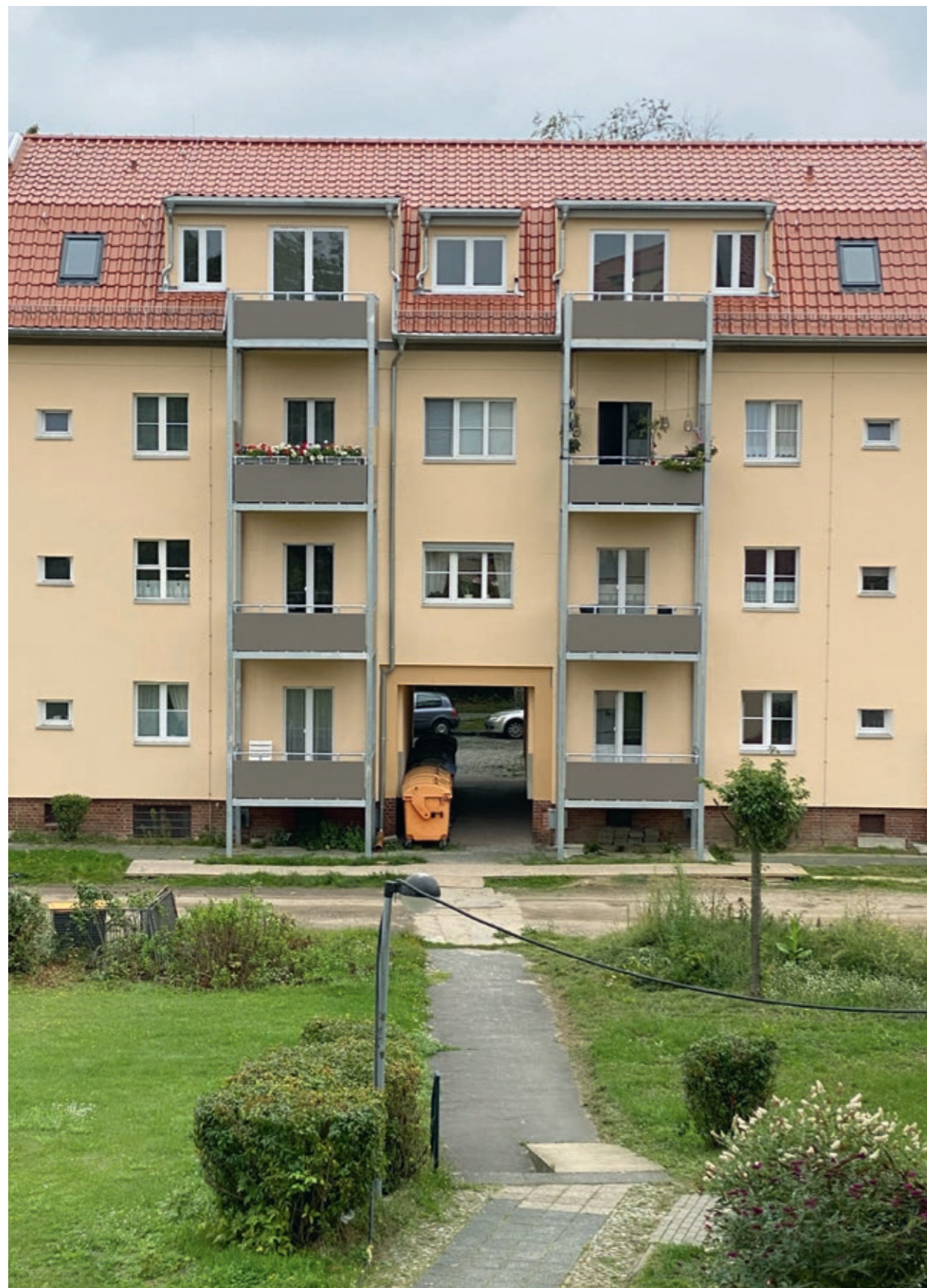
Balkonanbau in unserer Wohnanlage in Mariendorf
